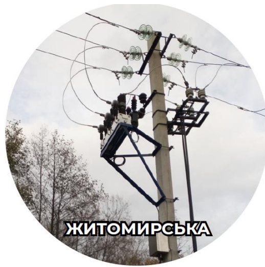
Аварійний вимикач мережі
